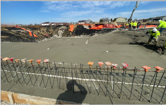
Lap pool floor pour in process
